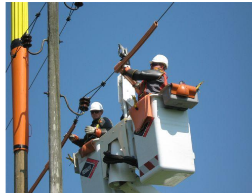
20 000 Volt Arbeiten unter Spannung
