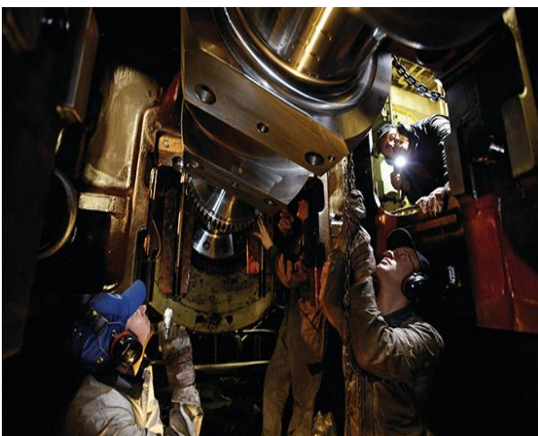
Montage einer Kurbelwelle im Bauch eines Schiffes unter schwierigsten räumlichen und klimatischen Bedingungen.
