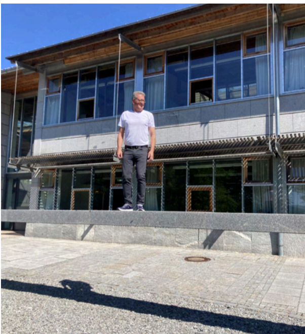
Fußgängerbrücke aus Granit
